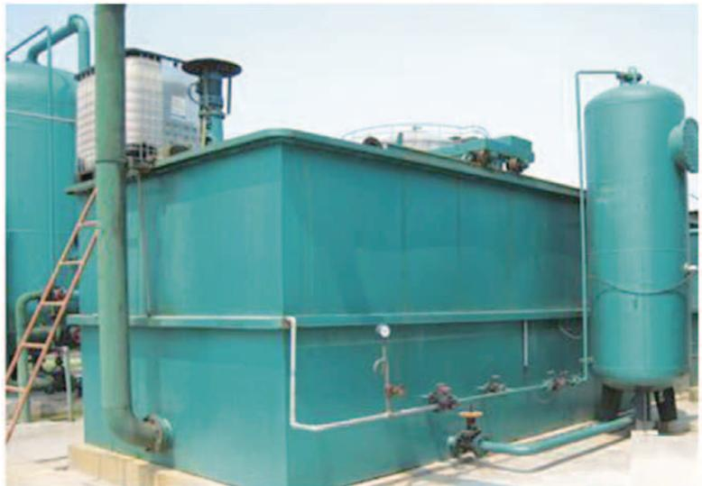
污水零排放设备是生物技术与膜技术相结合的高效生化水处理技术。该技术将生物膜与传统污泥法相结合，实现了水力停留时间和污泥龄的完全分离，污染物去除率高。由于采用先进的膜生物反应器技术，使系统出水水质在各方面均优于传统的零排放废水处理设备。由于膜分离效率高，无需设置沉淀过滤等固液分离设备，无需反洗，出水悬浮物浓度远低于传统固液分离设备，使整个系统简单化。可滤除细菌、病毒等有害物质，减少消毒设备和日用量，使管理和运行更加方便。
